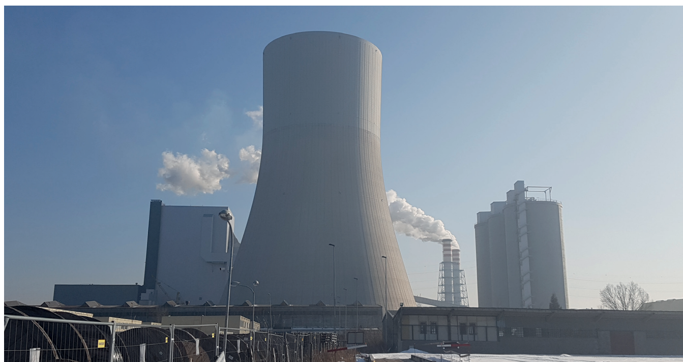
Elektrownia Kozienice budowa bloku 11
